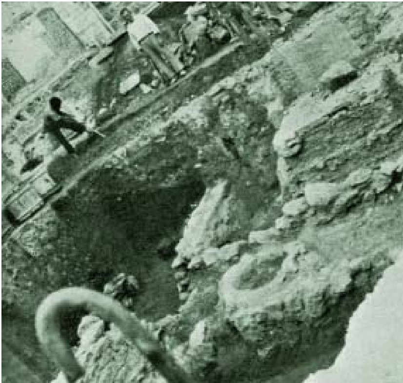
Vista general de la excavación en el Palau de la Generalitat (Valencia). Imagen publicada en el APL II. 1945.
