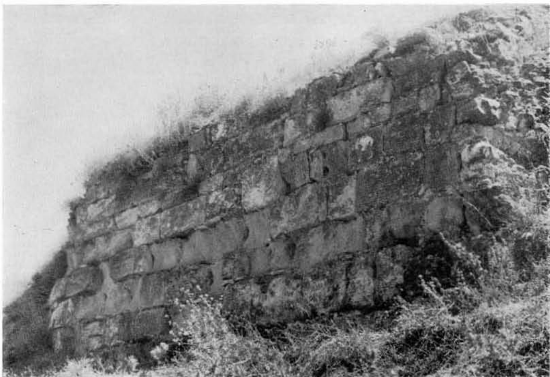
a.—Vista exterior de la cisterna.
