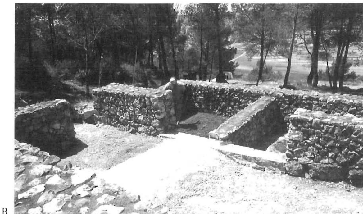
Lám. VII.— A: Superposición de estructuras de habitación del departamento 159, los muros inferiores corresponden a la Fase I. Año 1991. B: Colocación de los suelos del Conjunto 1. Año 1991.
