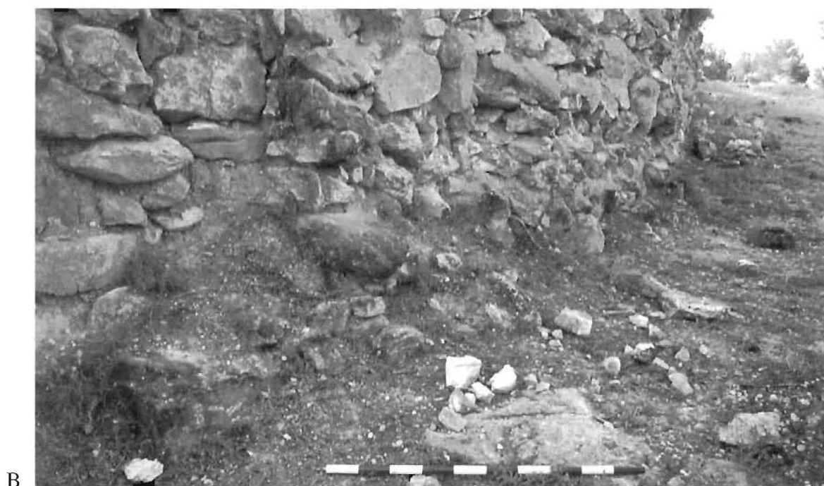
Lám. V.- A: Lienzo de muralla donde se aprecian los elementos verticales que marcan los arranques o ángulos de una posible torre (Torre X), hoy desaparecida. Año 1991. B: Detalle del arranque de la misma torre y restos de marcas de pala excavadora junto al jalón. Año 1991.
