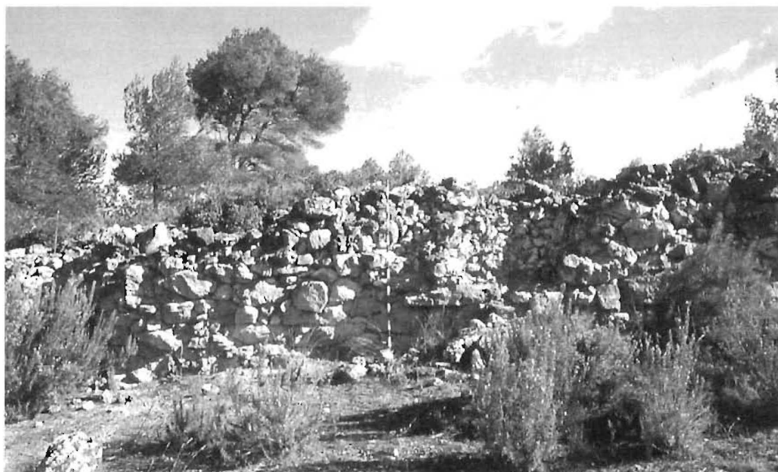
Lám. IV.— A: Estado de la muralla oeste y de la torre III antes de la restauración. Año 1990. B: Lienzo de la muralla antes de la restauración con evidentes muestras de su deterioro. Año 1990.
