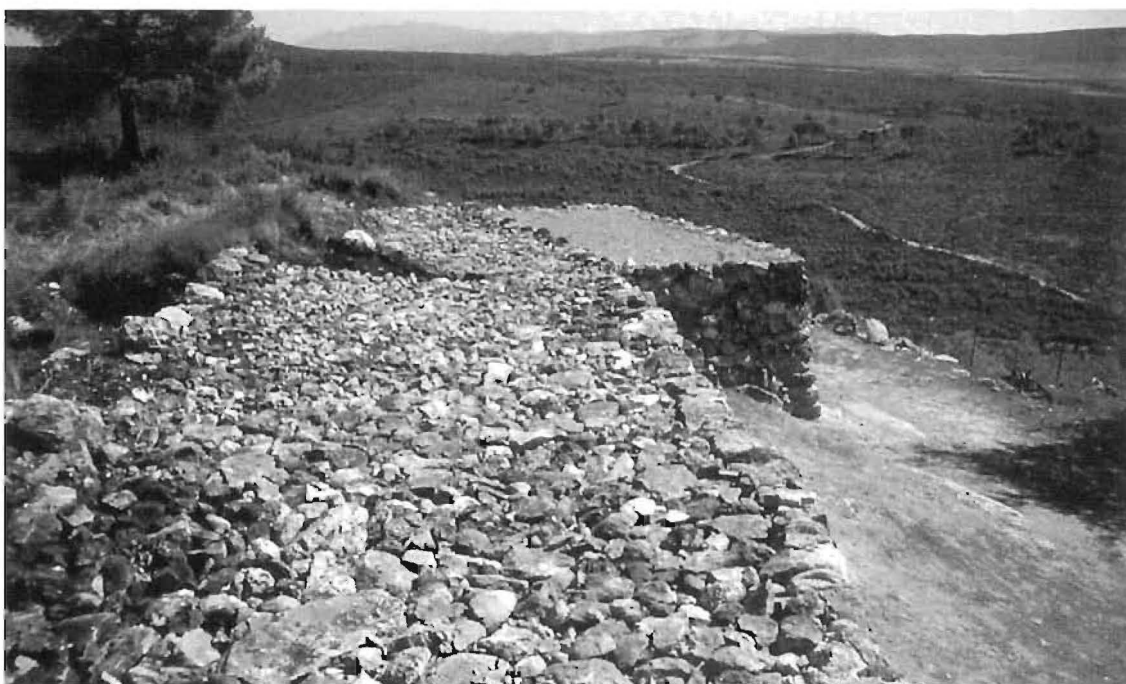
Lám. X.— A: Vista de la cara sur de la Torre II, una vez restaurada. Año 1995. B: Acabado del coronamiento de la muralla y de las torres. Año 1995.
