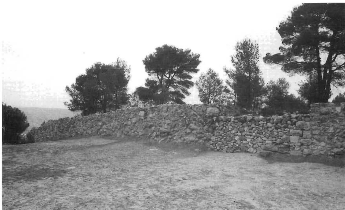
Lám. VI.— A: Limpieza del tramo central del frente oeste de la muralla donde aparece la entrada principal. Año 1991. B: Lienzo oeste de la muralla, una vez restaurado, con la puerta principal tapiada mediante piedras de menor tamaño para indicar claramente su provisionalidad. Año 1995.
