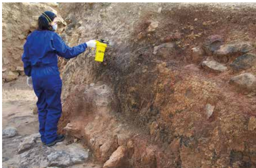
Fig. 2. Consolidación in situ de los revestimientos de muro mediante pulverización de silicato de etilo.
