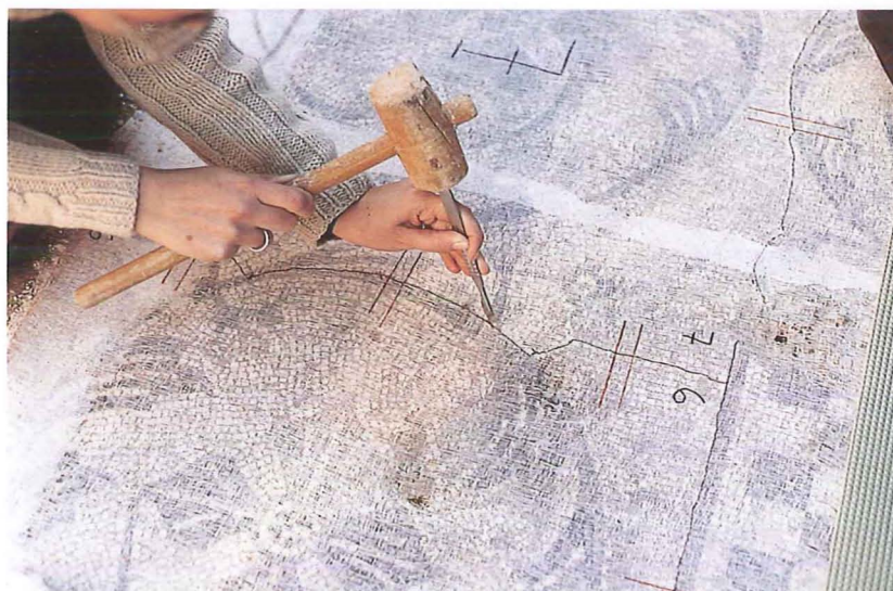
8. Corte de las telas entre líneas de cremallera con la ayuda de bisturí para permitir la separación de las secciones. Gas Natural SDG
