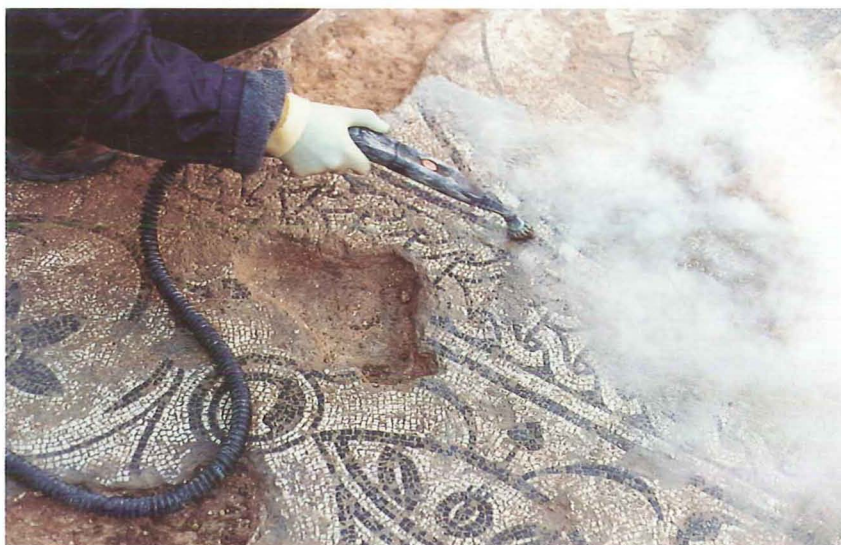
3. Tratamientos de limpieza del pavimento con vapor de agua. Gas Natural spg
