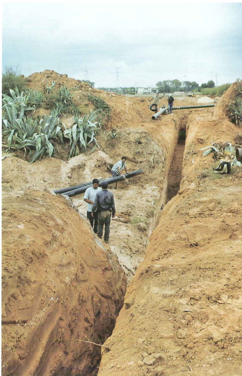
5. Trabajos de construcción del gasoducto Benifaió-Picassent. Gas Natural SDG
