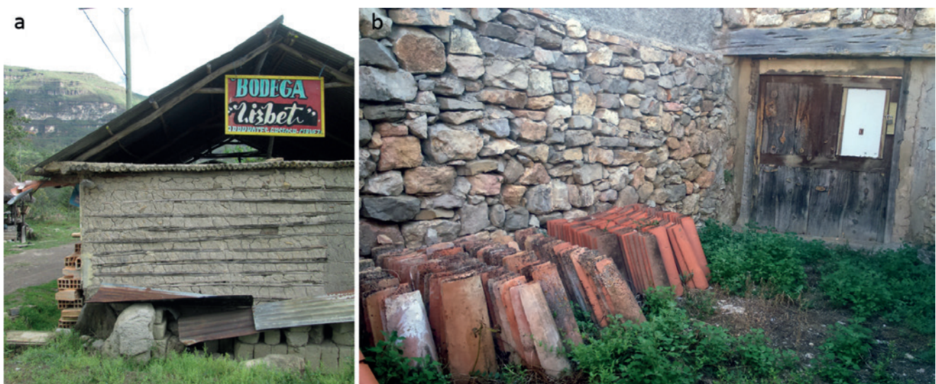
Figura 4.26. a. Almacenamiento de materiales constructivos –adobes y ladrillos–, cubiertos para su protección, junto a una edificación de muros de bajareque (Cocachimba, Perú). b. Almacenamiento de tejas en el interior de un patio (Abejuela, Teruel).
