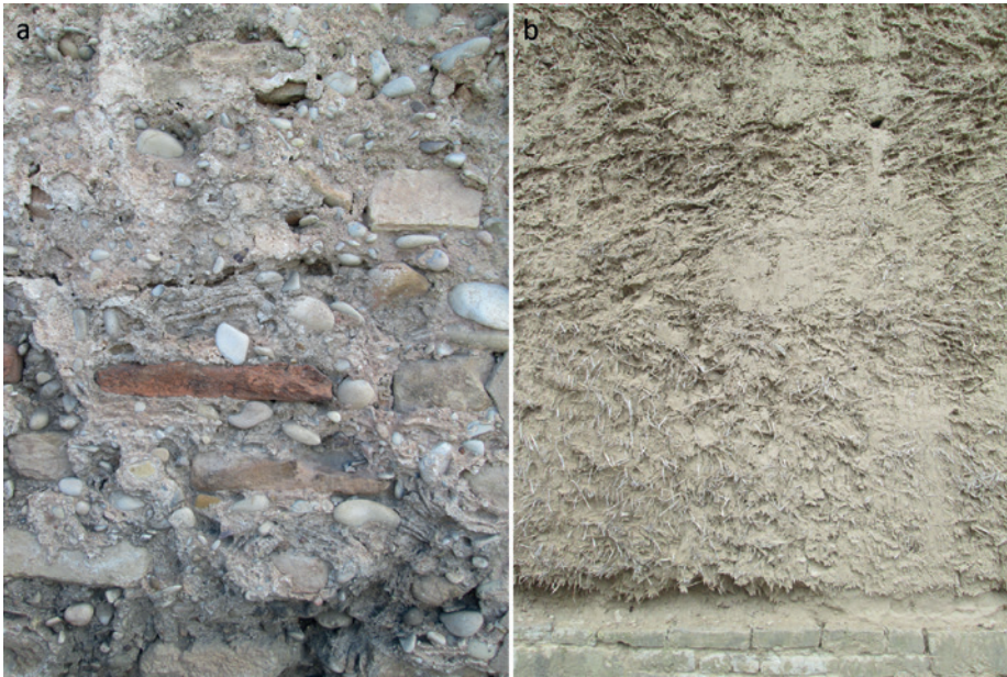
Figura 4.4. a. Detalle de un muro construido mediante la técnica de la tapia valenciana, habiéndose incluido guijarros y elementos cerámicos en el mortero (Valencia). b. Superficie de un alzado de tierra maciza con abundante paja (Jüdingdorf, Alemania).
