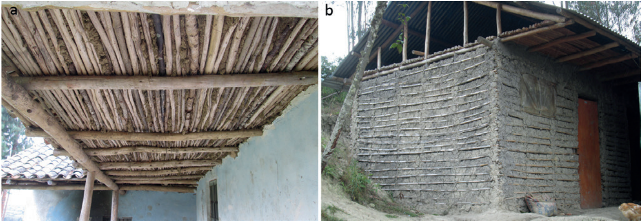
Figura 4.1. a. Cara interna de una cubierta construida con troncos largos y estrechos, unidos con mortero de barro (Cruzpata, Perú). b. Vivienda de muros de bajareque, edificados con una estructura de cañas horizontales y barro (Luya, Perú).
