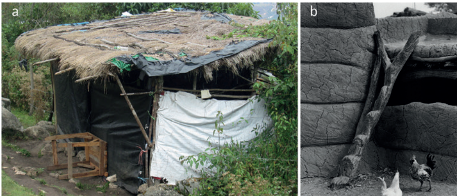
Figura 4.13. Otros usos de la madera en las edificaciones. a. Troncos reforzando la sujeción de la cubierta (Kuélap, Perú). b. Escalera fabricada a partir de un tronco (Ouangara, Níger) (Frobenius-Institut, 1990, fig. 9).
