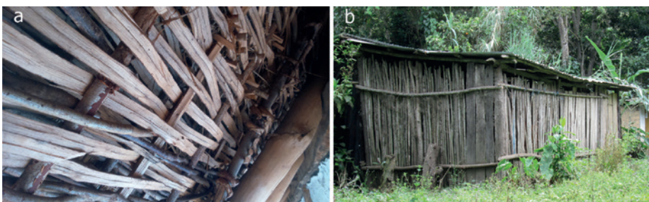
Figura 4.11. Ejemplos del uso de elementos de madera para cerramientos en la construcción. a. Varas cortadas por la mitad y entrelazadas en el interior de la estructura de una cubierta en Butser Ancient Farm (Hampshire, Inglaterra). b. Construcción con alzados de troncos, varas y tablas (Cocachimba, Perú).
