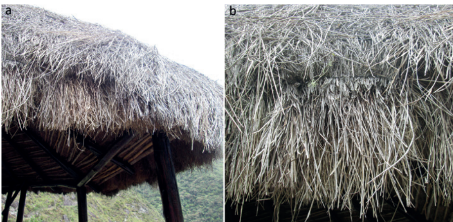
Figura 4.6. a. Estructura abierta y techada, utilizando tallos vegetales de pequeño calibre (Chachabamba, Perú). b. Detalle del alero de la cubierta.
