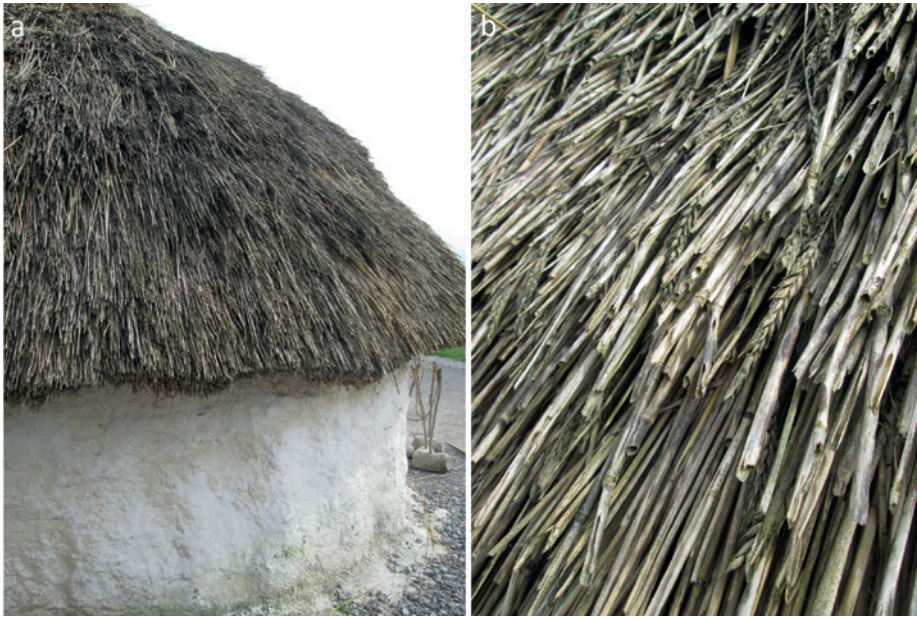
Figura 4.5. a. Estructura construida con alzados de bajareque revestidos y cubierta vegetal, en el centro de visitantes de Stonehenge (Wiltshire, Inglaterra), elevada de acuerdo con los datos de las excavaciones en el cercano enclave de Durrington Walls. b. Detalle del exterior de la cubierta.
