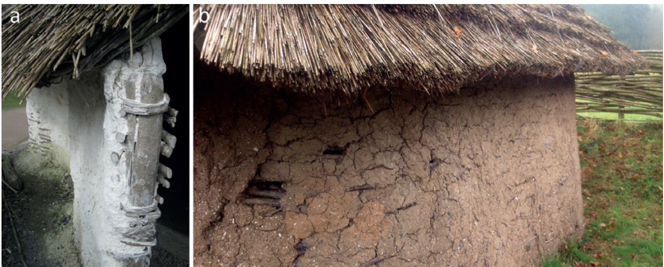
Figura 4.16. a. Alzado de bajareque con varas de madera entrelazadas cubiertas por mortero, en la reconstrucción de una vivienda prehistórica en el centro de visitantes de Stonehenge (Wiltshire, Inglaterra). b. Pared de bajareque en una de las viviendas prehistóricas experimentales en Butser Ancient Farm (Hampshire, Inglaterra).
